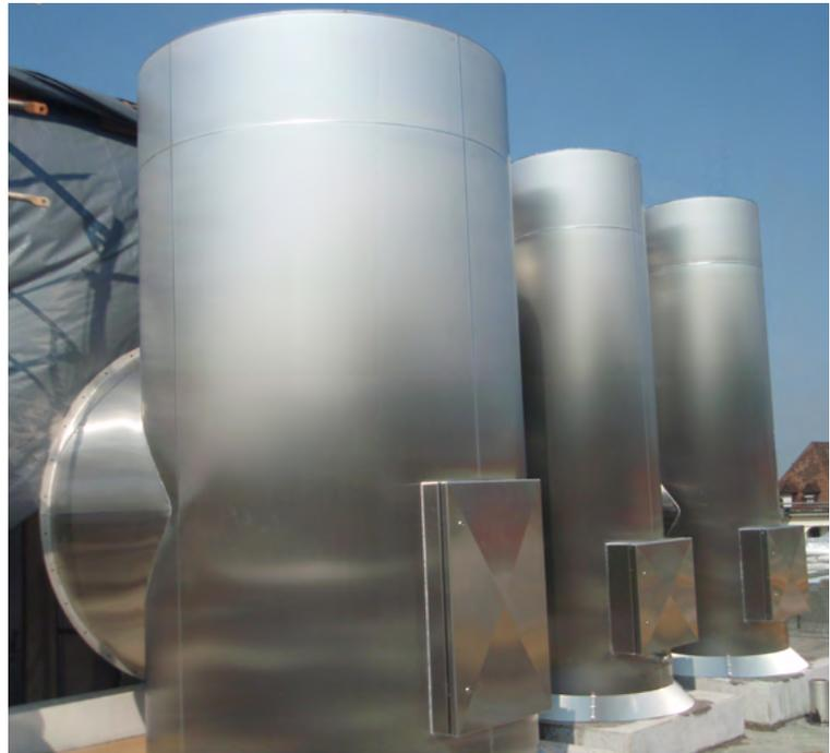
**Schweißnaht** umlaufend ausgeführt als WIG-Schweißnaht
