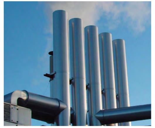
TA-Luft-konform konzipiert: auf einem Stahltraggestell angebrachte Fortluftturmreihe auf einem Produktionshallen-dach mit Verbindungsverrohrungen zu den Ventilatoren
