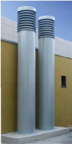
Außen gleich, Funktionen verschieden: Aussenluft-ansaugung über das Lamellenfeld, Fortluft senkrecht ausblasend bei abgeschottetem Lamellenfeld
